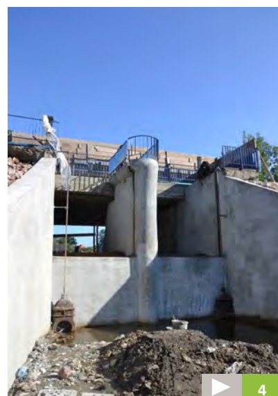
Prace przy zalewie w Szydłowcu
