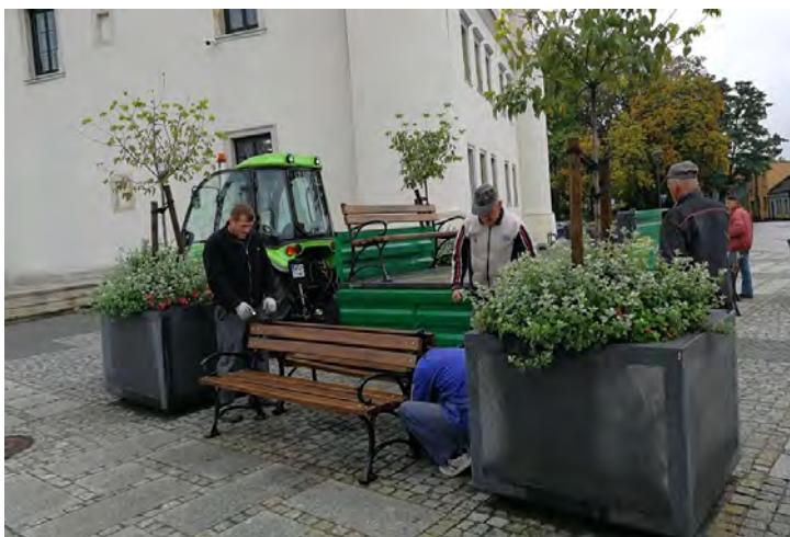
Pracownicy Referatu Gospodarki Komunalnej Urzędu Miejskiego zamontowali na rynku ławki, które zostały odnowione i zabezpieczone przed działaniem warunków atmosferycznych.
