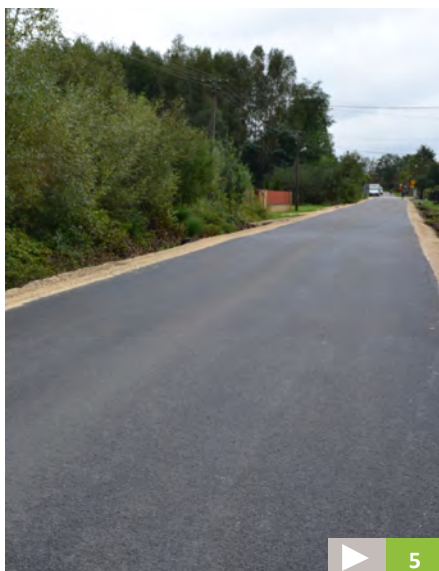
Przebudowa drogi w Zdziechowie
