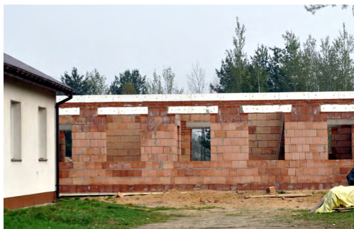
Budowa lokali socjalnych przy ul. Piaskowej w Szydłowcu
