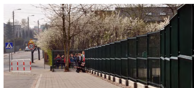
Budowa zatoki postojowej przy ul. Wschodniej w Szydłowcu – przy PSP w Szydłowcu. Wartość wykonanych prac: 33.461,36 zł
