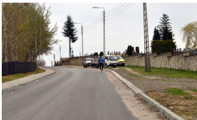
Zakończyła się przebudowa ulicy Kamiennej w Szydłowcu. Wartość wykonanych robót - 130.864,03 zł
