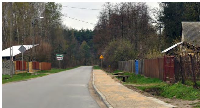
Budowa chodnika przy ul. Narutowicza, strona prawa do ul. Książek Nowy. Wartość wykonanych robót: 33.586,91 zł
